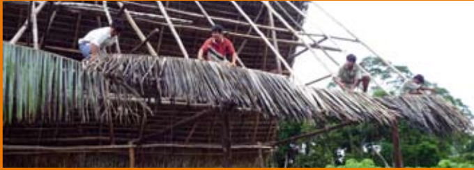
Die Männer beim Decken des Schuldaches. Jeweils zwei große Palmblätter werden versetzt über die darunter liegenden gelegt und mit lianenartigen Schnüren fixiert.
