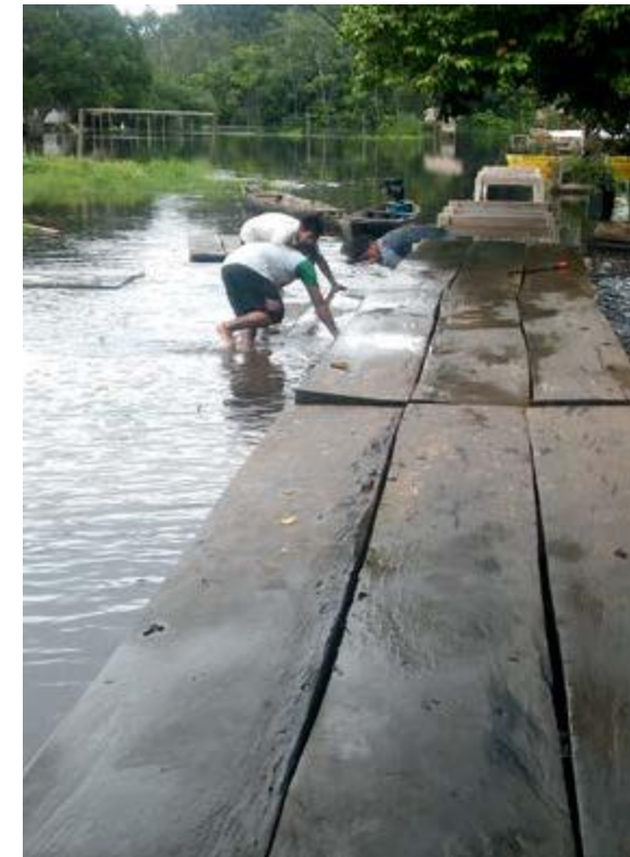
Der Hochwassersteg wird befestigt
