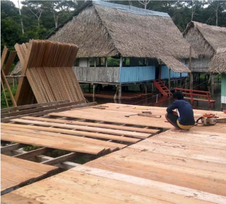
Erweiterungsbau der Klinik. Der Fußboden ist fast fertig. Alles wird in Eigenleistung erledigt!
