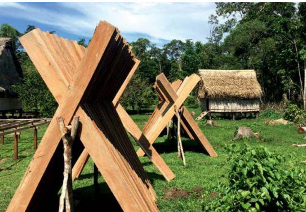
Die Bretter für den Erweiterungsbau der Klinik werden in der Sonne getrocknet
